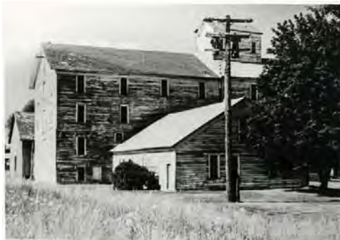
Flour Mill Complex ca 1987.jpg
